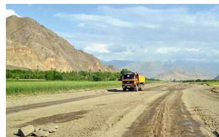
Lkw um Lkw mit Füllmaterial für die Fluggiste
